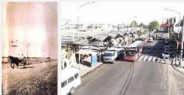
Izquierda: Camino a González Catán (hoy Ruta 21) en 1946. Derecha: Ruta 21 en la actualidad
