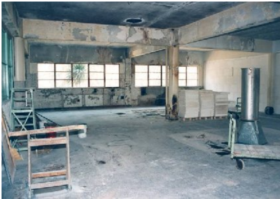
Construcción de oficinas del Primer Piso del Sector "Nicolás Avellaneda". Se observan las paredes y techo de la antigua fábrica. 109
