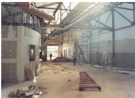
Construcción del sector Luis Federico Leloir. En la imagen se observa lo que iba a ser la bedelía y sala de profesores de Ciencias Económicas. Actual oficina de alumnos. 93
