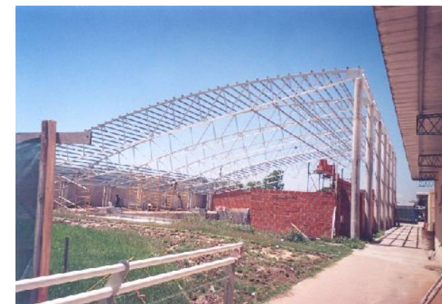
Construcción de la piscina. 2006. 117
