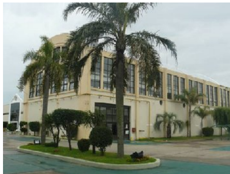
Vista de la calle central y el Gimnasio. Febrero 2011. 114
