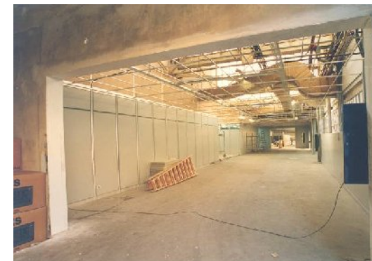
Construcción del sector Bernardo Houssay.
