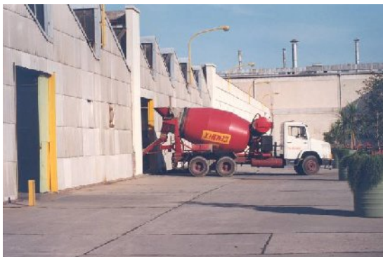
Construcción de las instalaciones de la UNLaM. Se observa la estructura edilicia de la antigua fábrica Chrysler. Vista de la actual calle principal. 129
