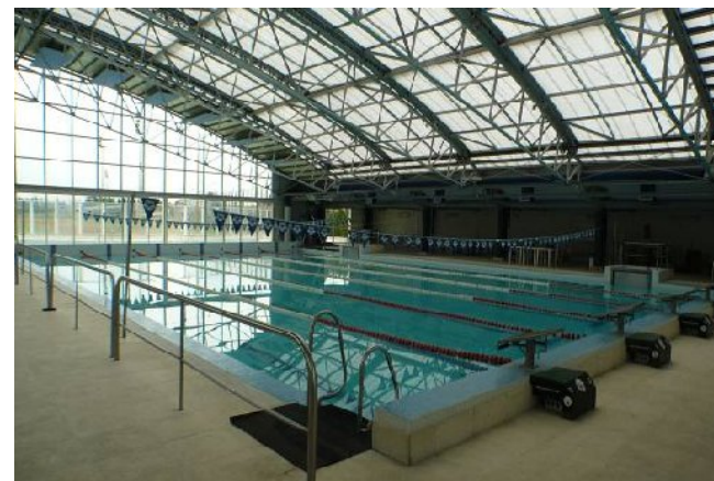
Pileta semiolímpica climatizada. Febrero 2011. 116
