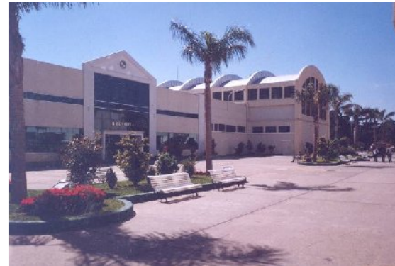
Vista desde la calle principal del frente de la nueva Biblioteca. 2006. 112
